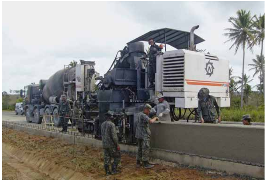
Wirtgen Gleitschalungsfertiger: Der Highway soll durch Betonleitwände sicherer werden.
