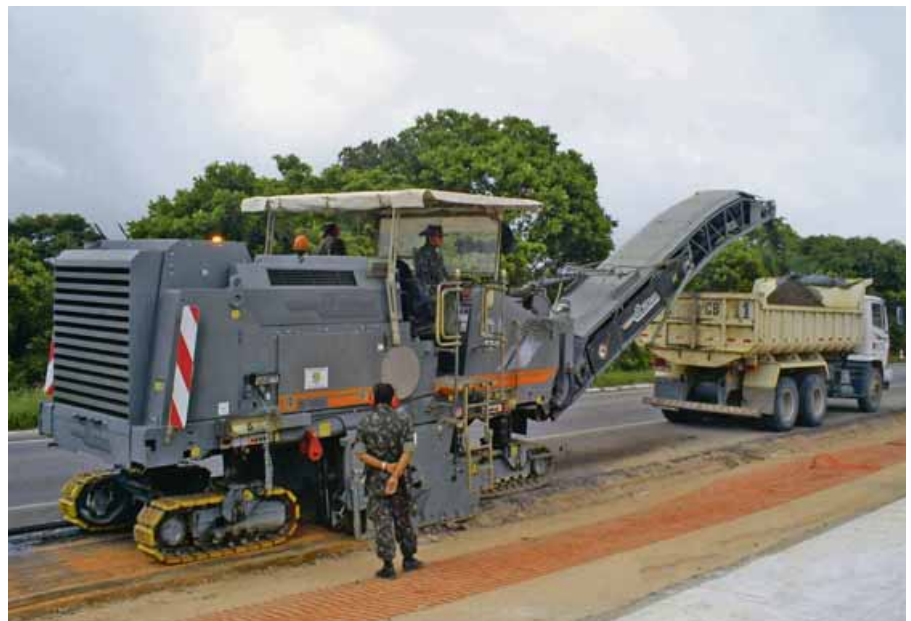
Wirtgen Kaltfräsen: Bewährte Partner bei der Instandsetzung der 30 Jahre alten BR 101.
