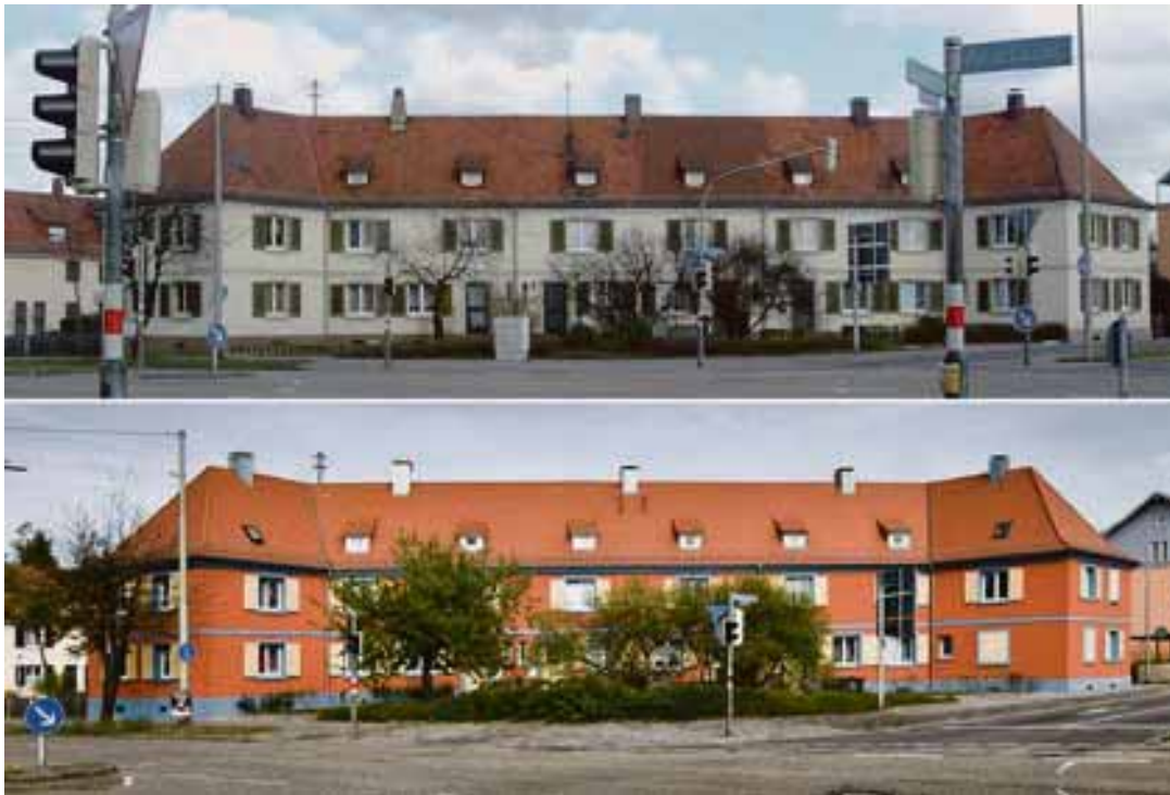
Der Vorher-Nachher-Vergleich zeigt die Veränderung. Die „neue alte“ Fassade erstrahlt wieder im originalgetreuen Baustil.
