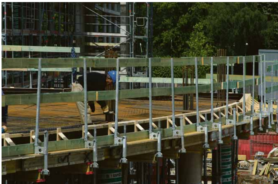
Die Sicherung der elliptischen Deckenränder ist mit der Protecto-MZ-Konsole ganz leicht. Im Bild ist auch die Pfostenverlängerung zu sehen, die einfach zwischen Aufnahme und Pfosten gesteckt wird und nach der Fertigstellung besonders starker Decken für eine immer noch ausreichend hohe Absturz-sicherung sorgt. Fotos: Hünnebeck
