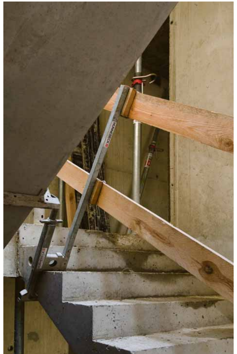
Topec-Randschalung mit Absturzsicherung. Als Aufnahme für die Protecto-Pfosten dienen MZ-Konsolen, die wie eine Schraubzwinge einfach an den Schaltafeln montiert werden. Auf's Fußbrett darf wegen der Deckenrandabschalung in diesem Fall verzichtet werden.
