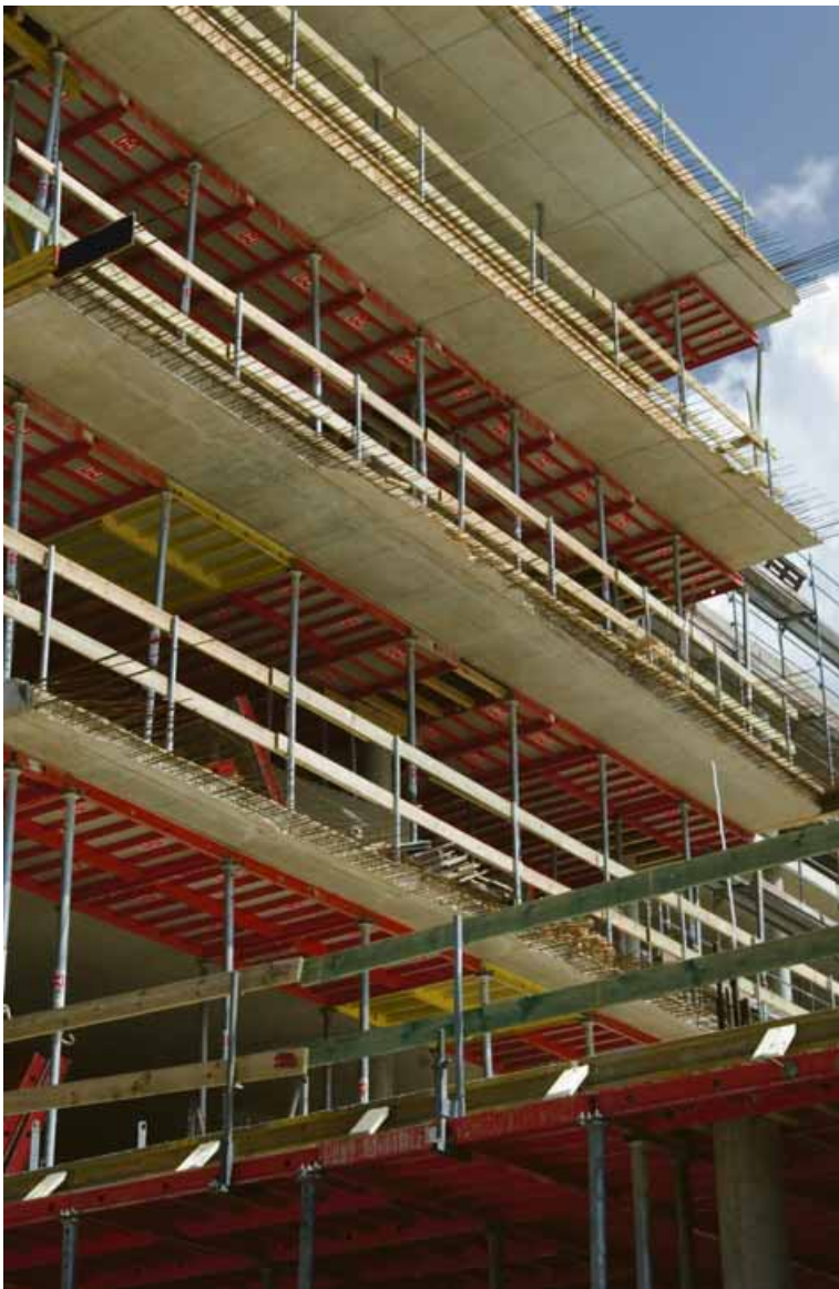
Perfekte Absicherung von Betonierabschnittsgrenzen auf der E.ON Ruhrgas-Baustelle mit dem Protecto-System.
