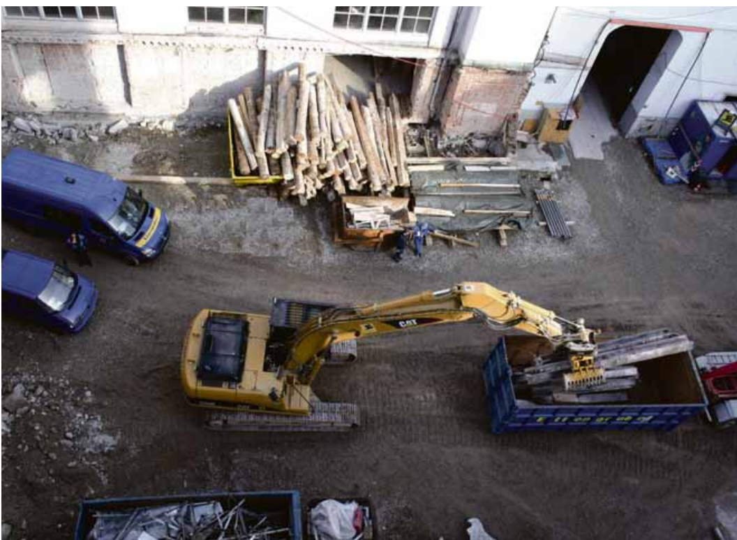
Der Cat 325DLN sortiert und verteilt den anfallenden Bauschutt auf Container.
