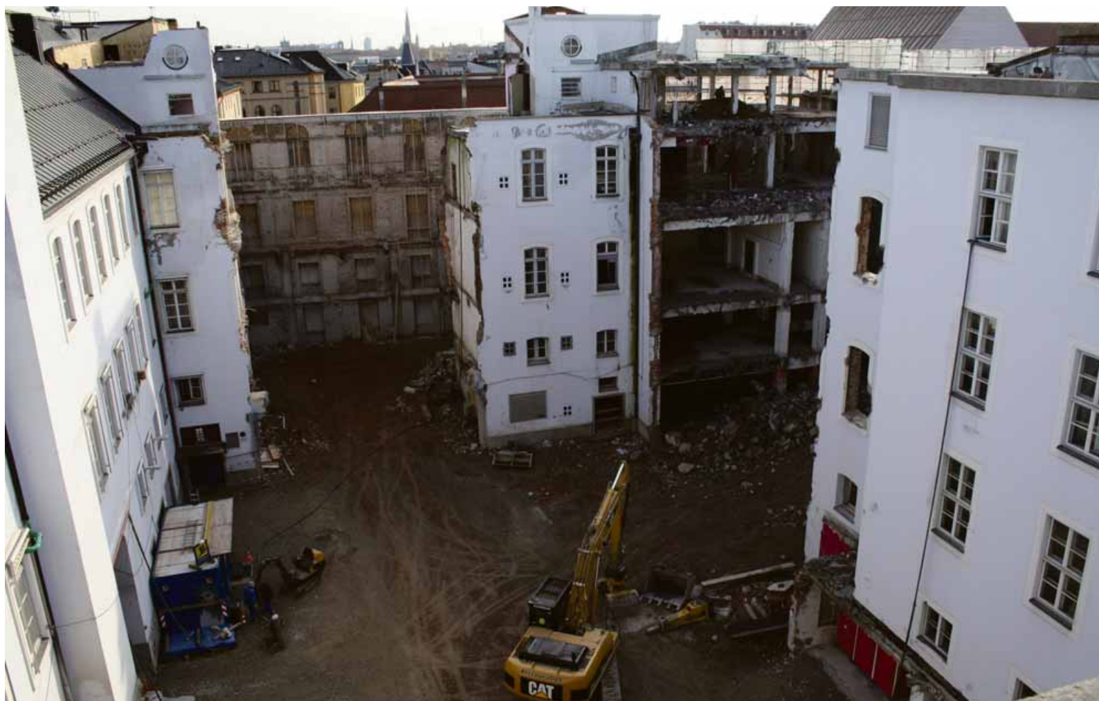
Damit genau die Teile stehen bleiben, die nicht beschädigt werden dürfen, wurde mit Hilfe eines Betonschneiders und einer Diamantsäge an der Fassade ein zehn Zentimeter breiter Schnitt gemacht. Fotos Zeppelin
