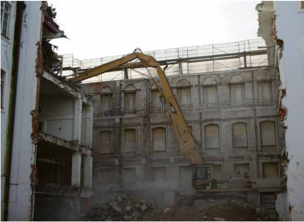
Absolutes Fingerspitzengefühl und viel Erfahrung sind beim Abbruch der ehemaligen Residenzpost mit dem Cat 345B gefragt.
