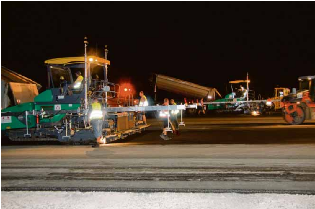
Einbau mit NAVITRONIC Plus® und VÖGELE Big-MultiPlex-Ski: Bei der Deckschicht übernahm das Ultraschall-Sensorensystem die Höhensteuerung. Dieses System gleicht selbst geringste Unebenheiten präzise aus und stellte so eine perfekte Ebenheit in Längsrichtung sicher.
