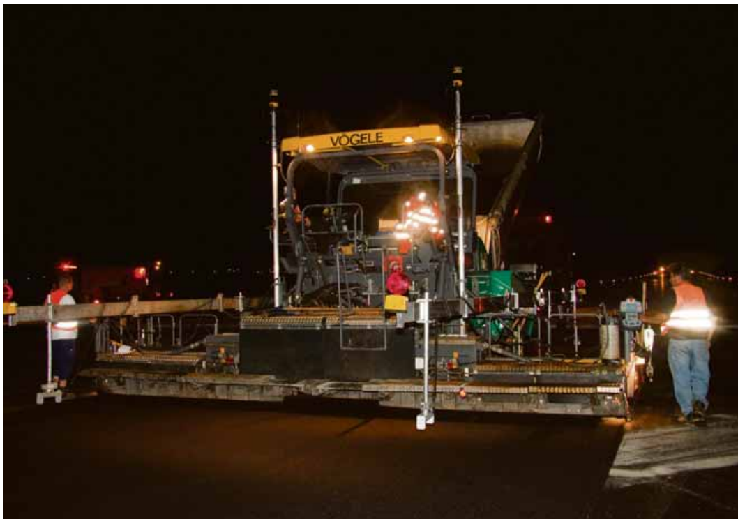
Sanierung der Start- und Landebahn mit Hightech von VÖGELE: 70 % höhere Einbauleistung dank NAVITRONIC Plus®
