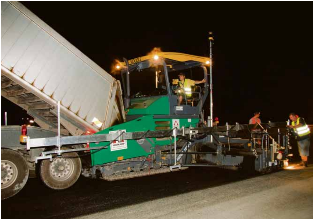
Zuverlässigkeit war entscheidend: Ein Lkw nach dem anderen übergab sein Mischgut an die SUPER Fertiger, die Nacht für Nacht ohne Ausfallzeit arbeiteten.
