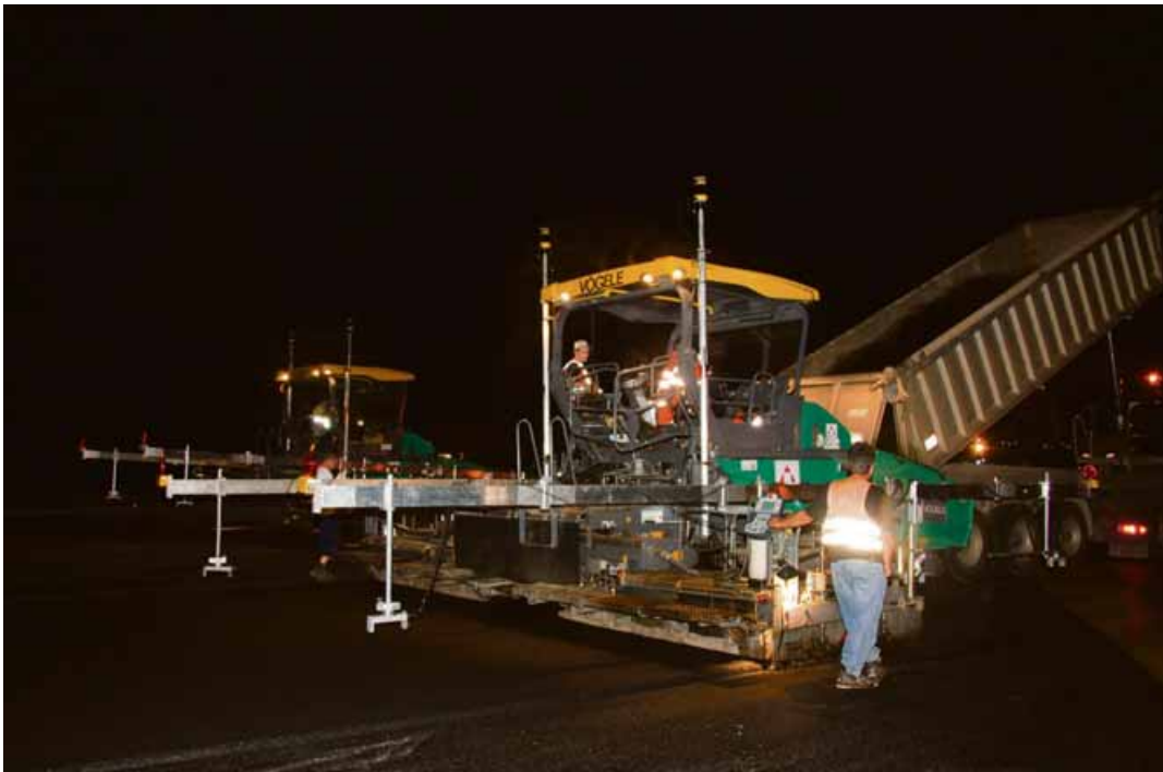
»Heiß an Heiß«-Einbau: Drei SUPER Fertiger stellten die Start- und Landebahn im Team her.
