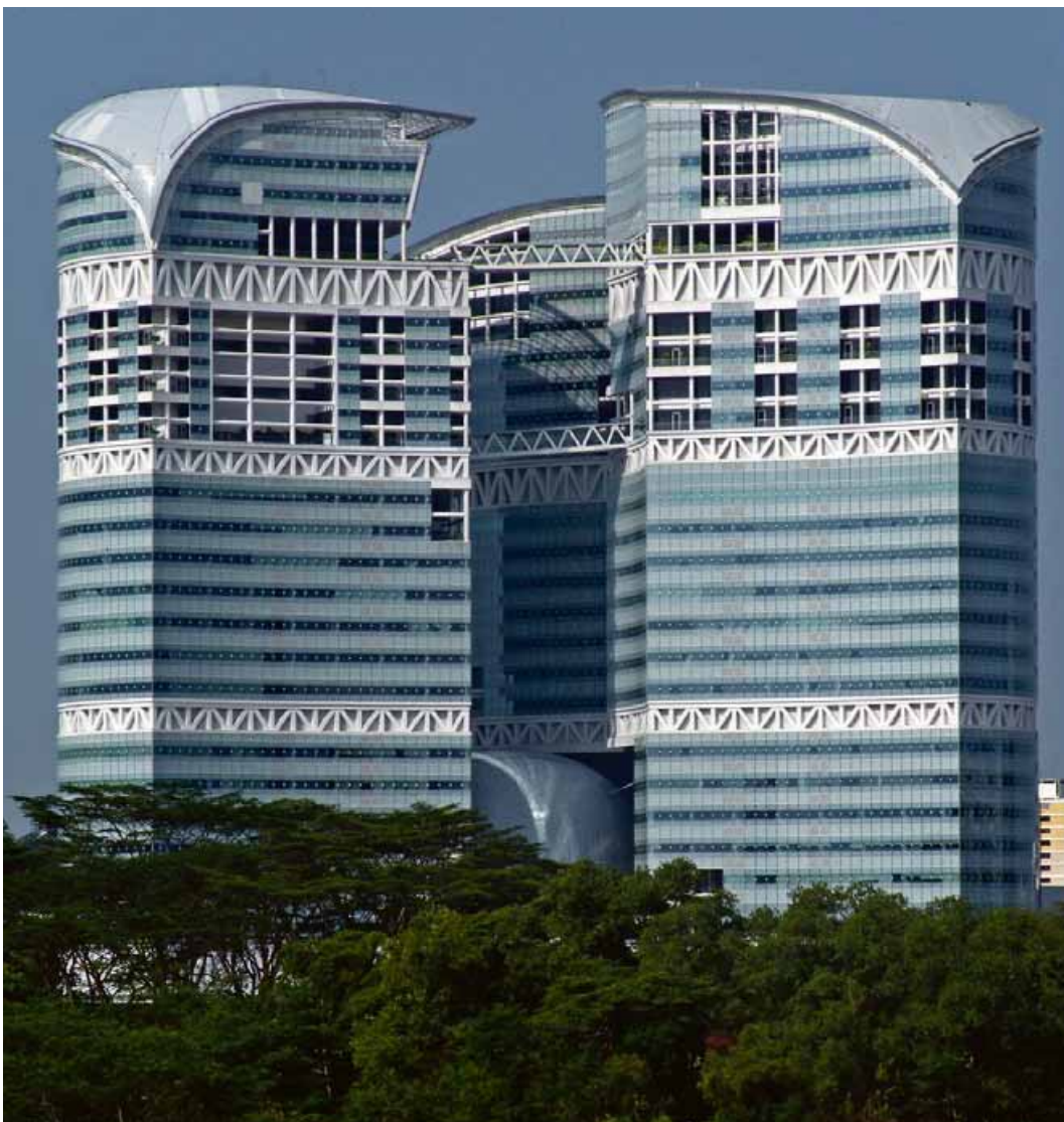
Fusionopolis: Hier „fusionieren“ Forschung und modernes Leben unter den Dächern der drei imposanten Türme. Mehr als 40.000 qm gestaltetes ipasol Sonnenschutzglas sorgen für optimales Klima, Blickschutz und Design.
