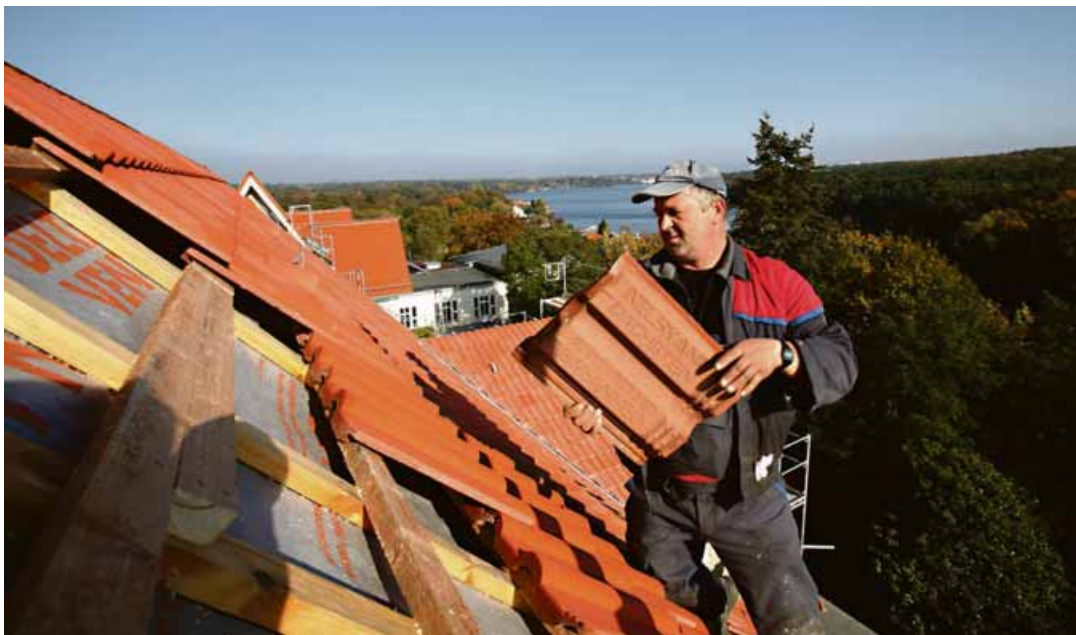
Das stark gegliederte Dach des Krankenhauses ist mit Neigungen von 50 bis 70 Grad konstruiert. Die Fassade wird im Jahre 2010 vollständig energetisch saniert sein.
