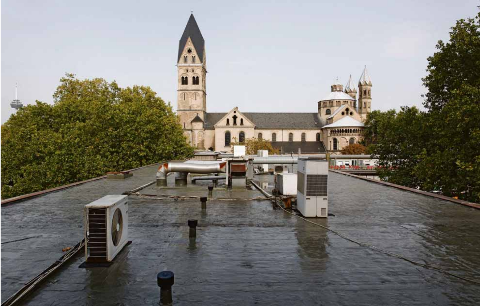
Die Kemperol-Verarbeitung erfolgte bei laufenden Klimaanlage während der normalen Arbeitszeiten.
