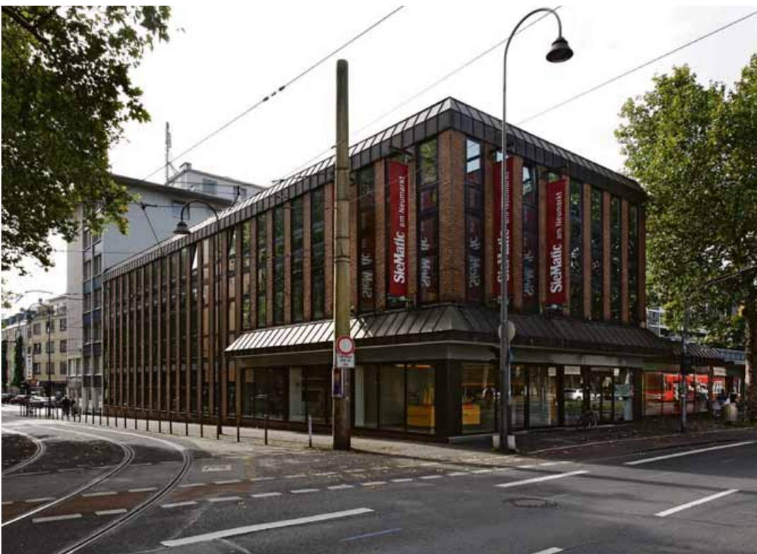
In der Kölner Innenstadt wurde das Flachdach eines Geschäftshauses mit Kemperol 2K-PUR neu abgedichtet.
