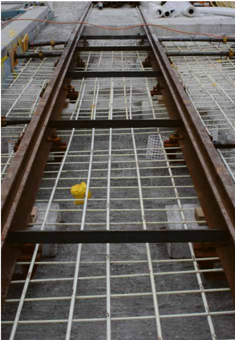
Schöck ComBAR: Mit ihren Materialeigenschaften eignet sich die GFK-Bewehrung besonders für Spezialanwendungen am Bau, bei denen Korrosionsbeständigkeit, reduziertes Gewicht und magnetisch neutrales Verhalten gefragt ist.
