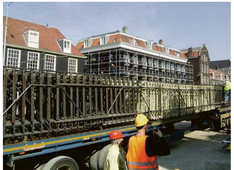
Kombination aus GFK- und Stahlbewehrung: Aufgrund der Zerspanbarkeit des Materials kann die Schlitzwand problemlos durchbohrt werden und bietet daher eine rationelle Lösung für den Tunnelbau. Fotos: Schöck Bauteile GmbH
