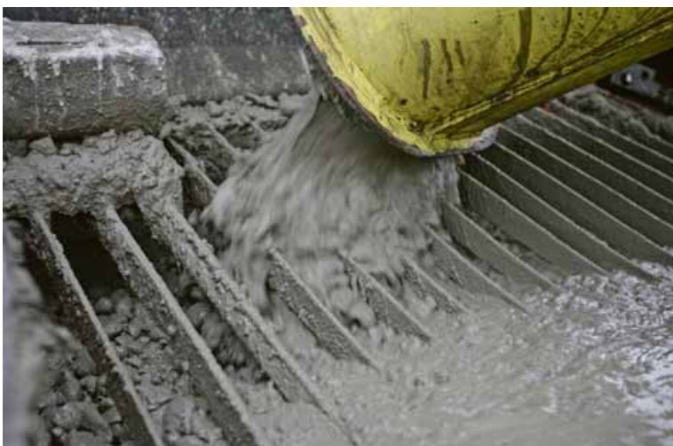
Bei engem Betoniertermin muss der Nachschub zügig fließen
