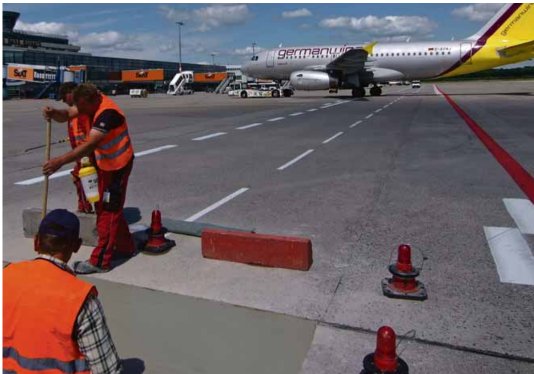
Der Flughafen Köln-Bonn setzte auf ChronoCem IR und ließ vier stark geschädigte Flächen im Roll- und Vorfeldbereich sanieren. Dreieinhalb Stunden lang wurde betoniert – und bereits wenige Stunden später rollten die ersten Flugzeuge sowie Fahrzeuge über die reparierten Flächen. Foto: HeidelbergCement/Fuchs
