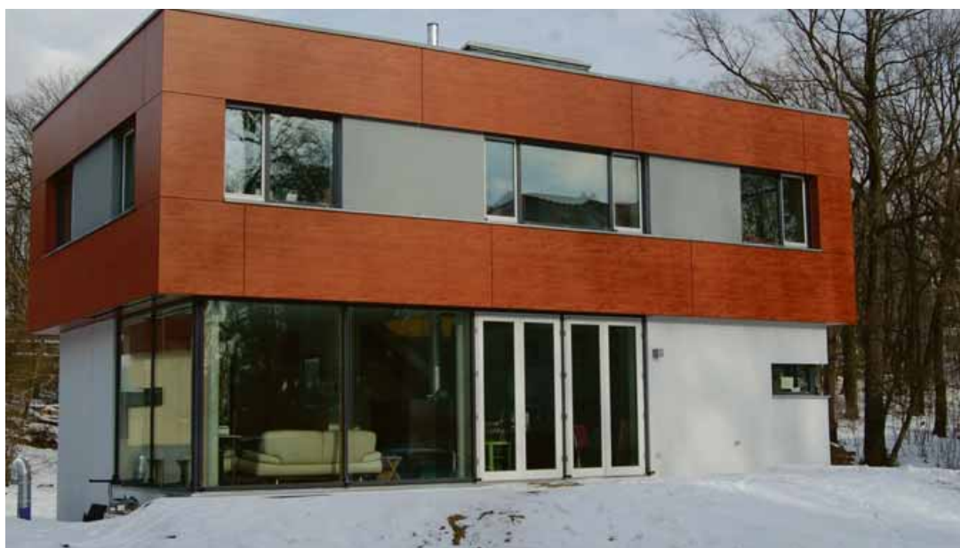
Passivhaus in Dresden: Das zweigeschossige Haus wird äußerlich geprägt durch ein verputztes Erdgeschoss und ein auskragendes Obergeschoss mit hinterlüfteter Vorhangfassade. Foto: Leipfinger-Bader
