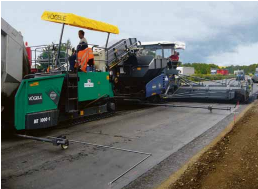
Hohe Steifigkeit macht's möglich: Die VÖGELE Standardbohlen-Technologie ermöglicht Einbauten in perfekter Ebenheit auch bei großen Arbeitsbreiten.
