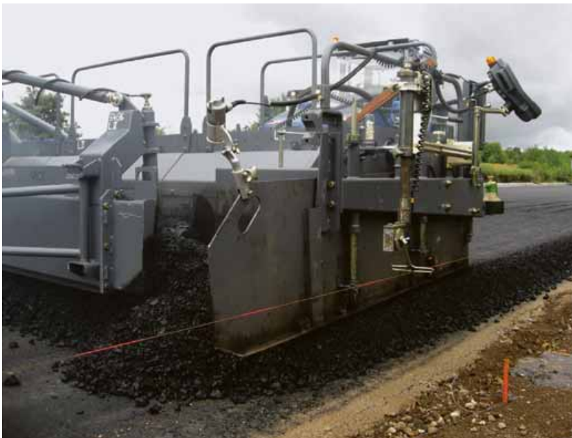
Hohe Steifigkeit macht's möglich: Die VÖGELE Standardbohlen-Technologie ermöglicht Einbauten in perfekter Ebenheit auch bei großen Arbeitsbreiten.
