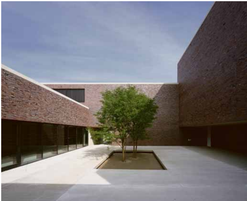
Ausgezeichnet beim Architekturpreis 2010 des Ziegel Zentrum Süd: das Kirchenzentrum Sankt Nikolaus in München-Neuried als kraftvolle Skulptur mit prägnanter Klinkerhülle. Foto: Michael Heinrich, München
