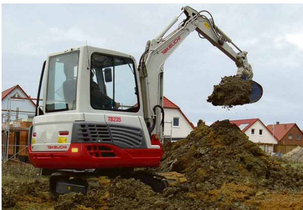
Der 3,5 t Bagger Takeuchi TB 235 kann ohne Probleme bei den vorbereitenden Arbeiten für eine Grünanlage eingesetzt werden
