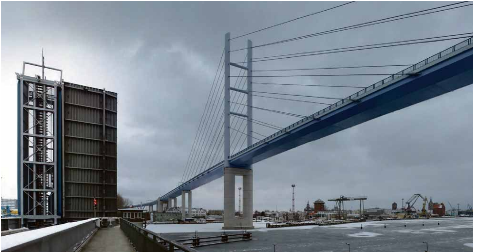
Vorgeschlagen für den Brückenbaupreis 2010: Die Rügenbrücke verbindet Stralsund mit der Insel Rügen
