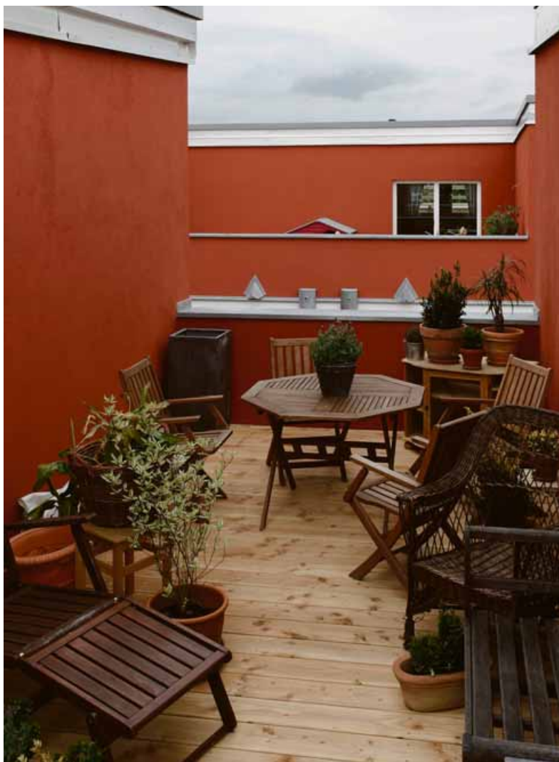
Als Nutzschicht wurden Holzdecks auf den Dachterrassen verlegt.
